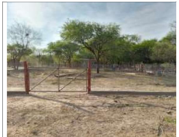
Terminando el cercado. Kurz vor Beendigung der Umzäunungsarbeiten.
